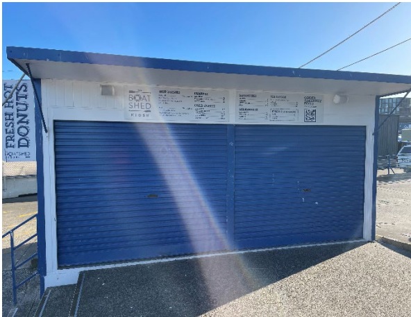
Photo 94: Overview of Kiosk
